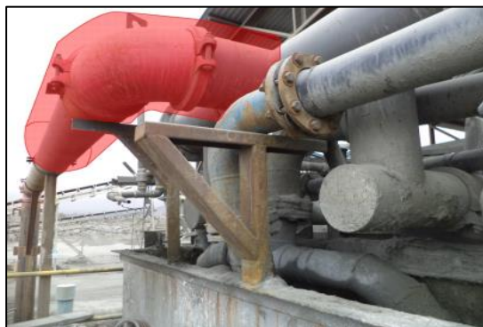
Imagen 1. Revestimiento a implementar en el ducto -en curva de 90°- en sector de flotación
